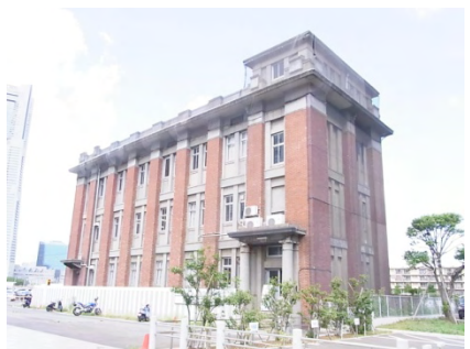
旧横浜生糸検査所附属倉庫事務所 (現 北仲 BRICK)
