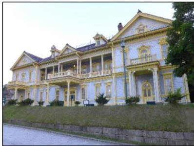
函館市元町 旧函館区公会堂(国重要文化財)
