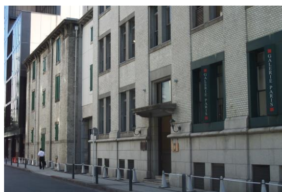
取り壊された三井物産横浜支店倉庫
