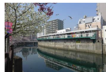
川面に映る都橋商店街ビル
