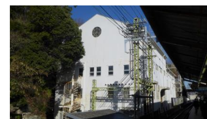
瀬戸変電所外観
