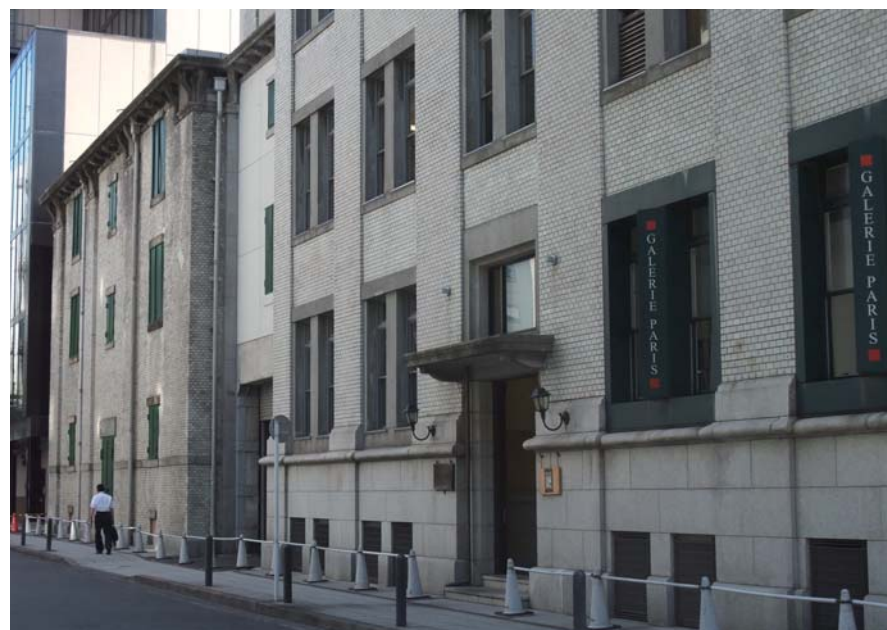
旧三井物産株式会社横浜支店事務所棟(手前)と倉庫(奥)
