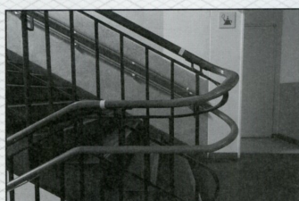
行政棟の階段。握りやすい木製の手摺り。
