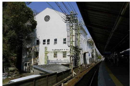
瀬戸変電所外観
