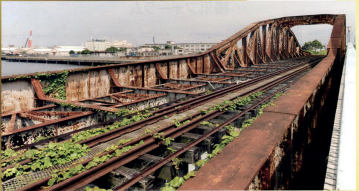
「瑞穂橋梁」リベットと溶接を用いた初の鉄橋 写真：田中光一
