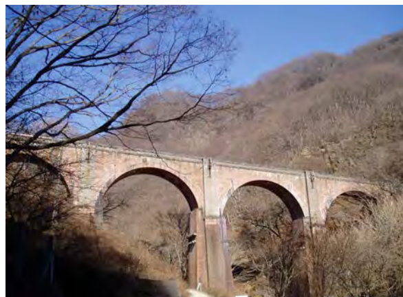
碓氷峠第三橋梁（群馬県安中市）国指定重要文化財 写真：米山淳一
