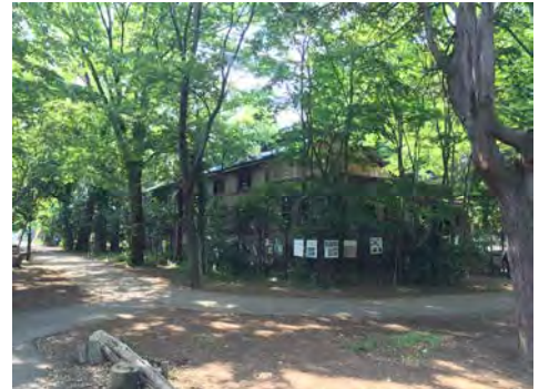
写真1 第一蚕室外観
