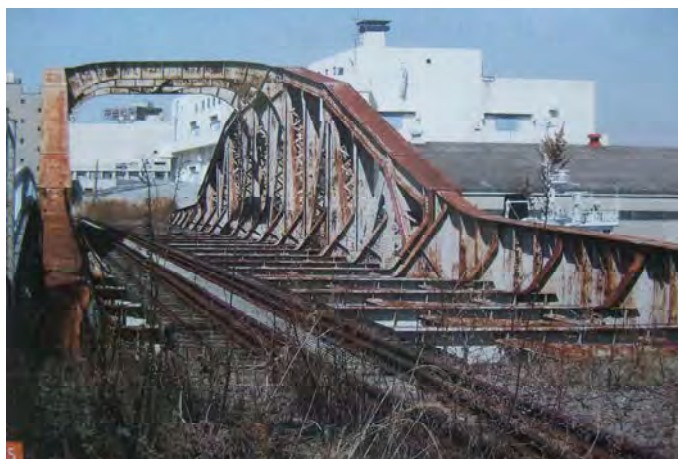
我が国初の溶接とリベットを併用した「瑞穂橋梁」
