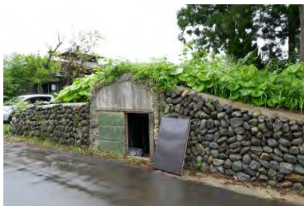
旧農事講習所地下冷蔵庫（明治 29 年頃）
