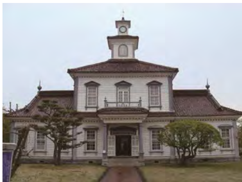
写真8 旧西田川郡役所
