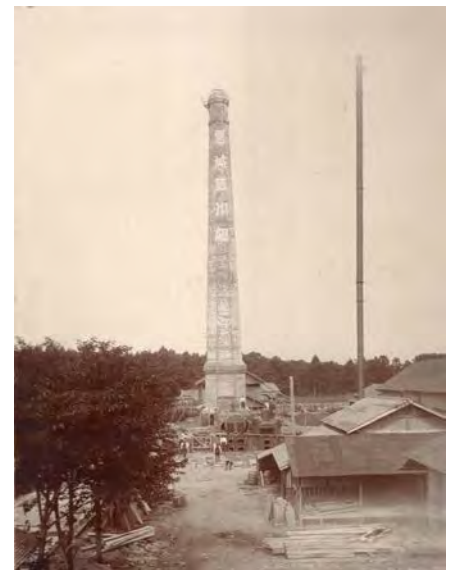
建設中の原ノ町工場
