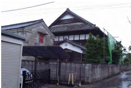
写真9 西側から見た外観。震災と雪害により、熨斗瓦が崩れていた
