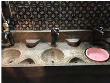
写真7 手の込んだ人造石研ぎ出しの洗面化粧台と本業タイル
