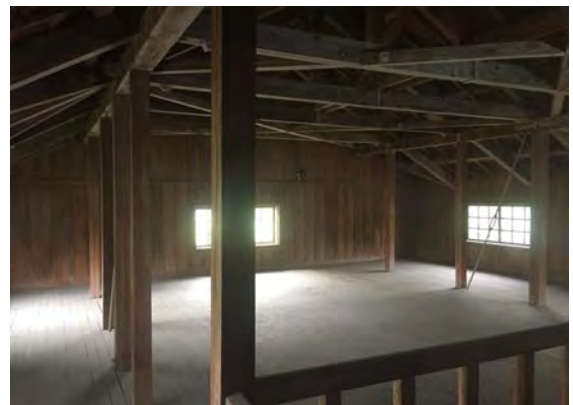
改修前写真2:第五蚕室2階小屋
