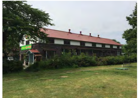
改修前写真1:第五蚕室(産直まゆの郷)外観
