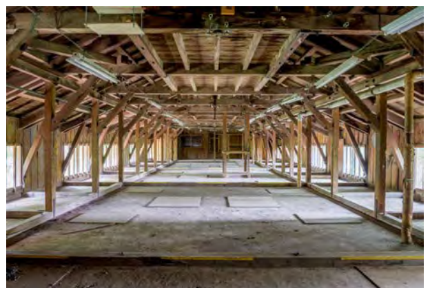
写真3 第一蚕室2階 木造トラス構造
