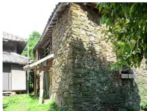
養蚕が行われていた石積み住宅
