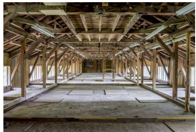
写真 4 木造トラス構造
