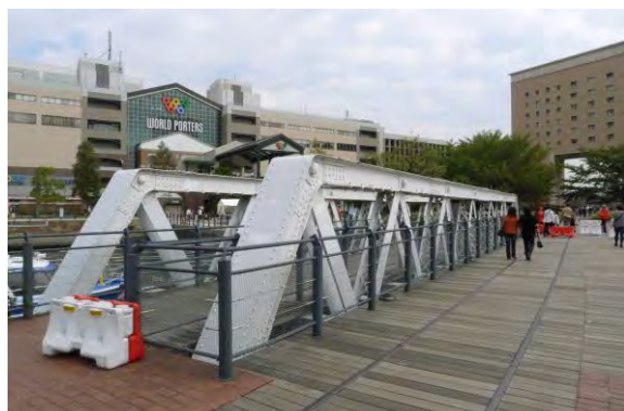
図4 引き込み線の大岡川に架かる橋梁の一部を移築
