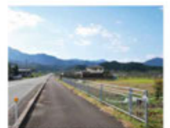
雪深い地域では雪を路肩の外に吹き飛ばすように陸間のパイプガードローンを設置
