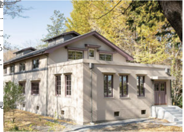
保存修理後の第一蚕室（南東からの眺め）
