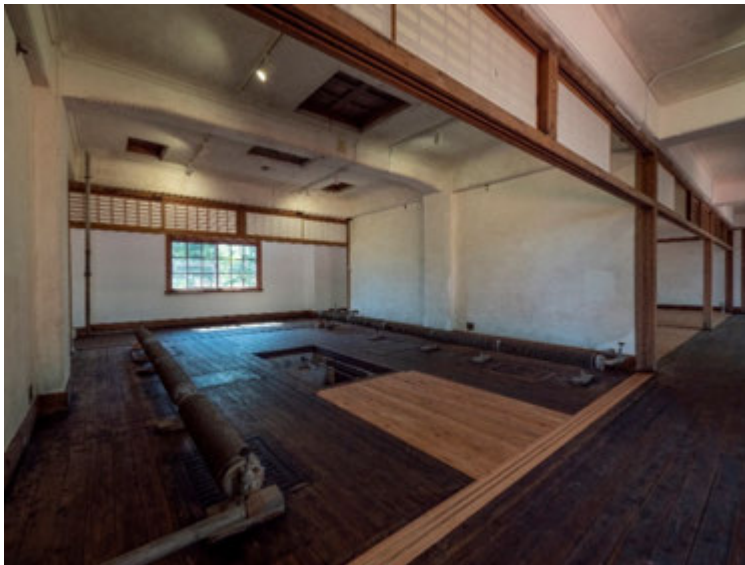
保存を重視し、火炉・放熱器・床板・蚕箔出し入れ痕などを遺した蚕室3（修理後）
