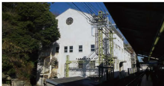
旧湘南電気鉄道(現・京急)瀬戸変電所の勇姿(写真 米山淳一)
