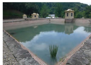
旧美敷水源地下水道施設（国指定重要文化財）
