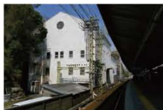
昭和4年建造の瀬戸変電所
