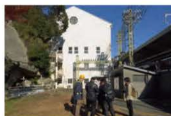
18. 旧湘南電鉄瀬戸変電所調査
