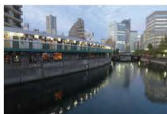
16. 野毛都橋商店街ビル
