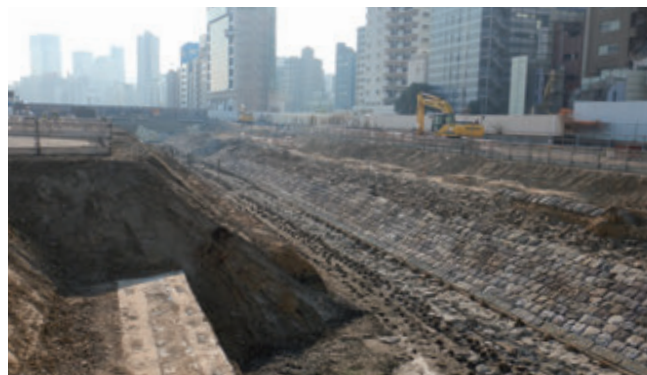
発掘された高輪築堤 (撮影/大島登志彦)
