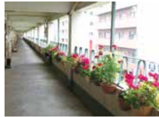
写真4：弁三ビル4階の共用廊下 (2012年当時)
