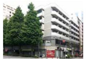
写真5：神奈川県住宅公社ビル外観 (2012年当時)
