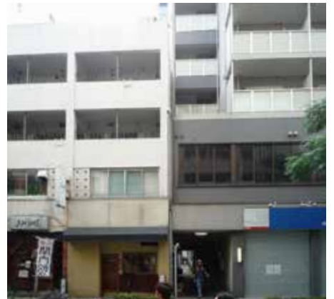
写真6：壁を接して連続する弁三ビル(左)と公社ビル(右)。公社ビルの中庭へつながる通路が見える。(2012年当時)
