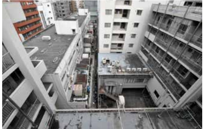
写真3: 公社ビル屋上から見た中庭と弁三ビル裏路地。右奥は隣接するマンション。(2012年当時)
