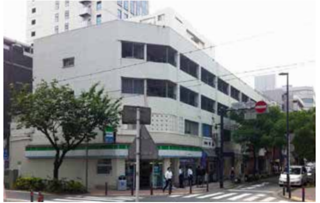
写真2: 弁三ビル外観 (2012年当時)
