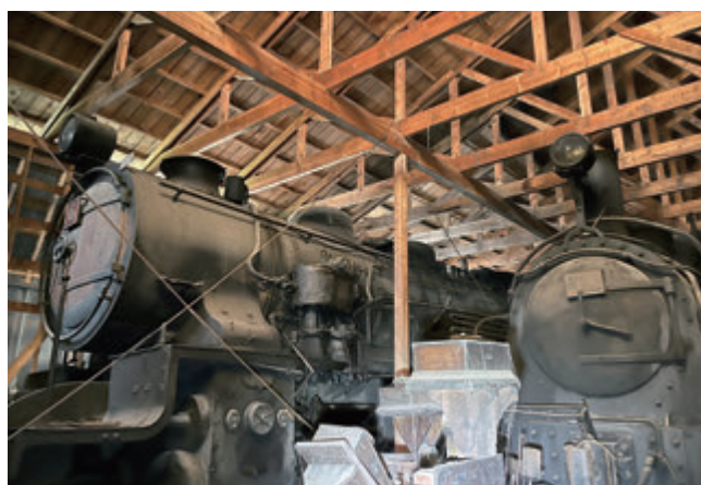
山田コレクション保管庫は立派な木造トラス構造
