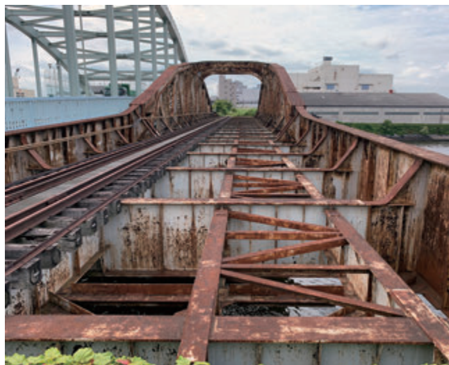
リベットと溶接を用いた我が国初の事例として貴重な瑞穂橋梁（神奈川区）
