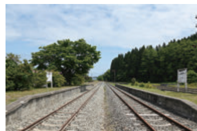
▲PC枕木化が完了した旧七戸町駅構内
