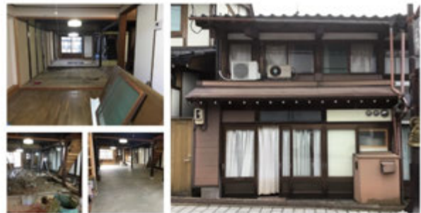
2019年 井波八日町通りに購入した一軒家・工事の様子
