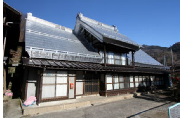
写真5. 付加された突き上げ屋根
