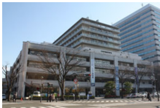
写真1. シルクセンタービル
