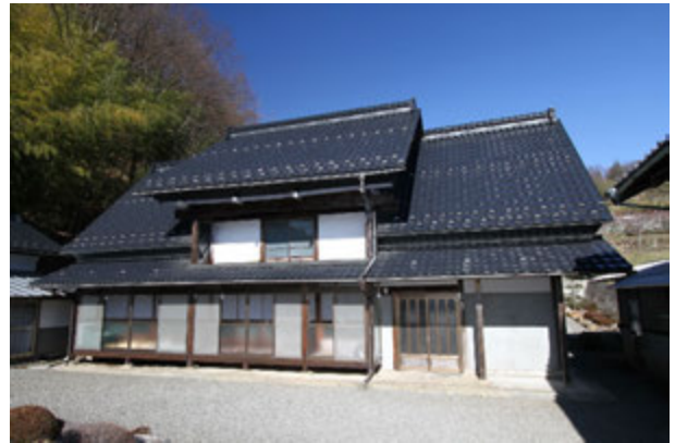
写真6. 建築当初からの突き上げ屋根
