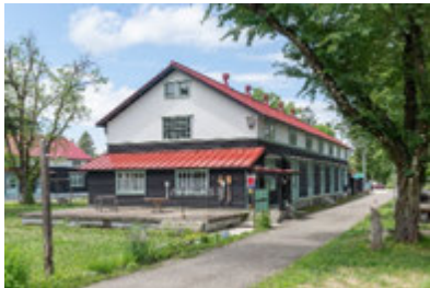
▲耐震改修後の旧第4蚕室
