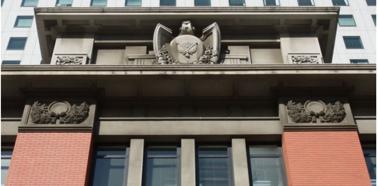
横浜第2合同庁舎（旧生糸検査所）：撮影 米山 淳一
