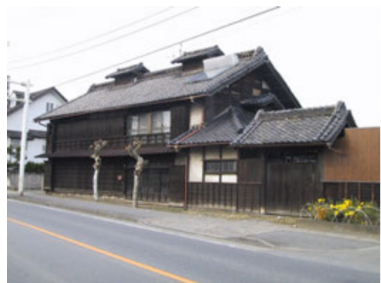
旧中山道倉賀野宿の街道に面した養蚕民家 （高崎市）現存せず
