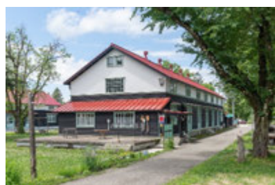
▲耐震改修後の旧第4蚕室
