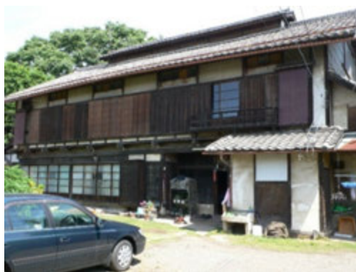
図2. 2階の柱を根接ぎして増築した民家
