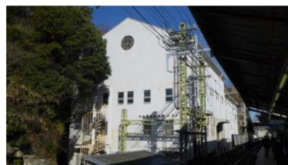
瀬戸変電所外観
