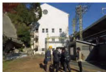
18. 旧湘南電鉄瀬戸変電所調査
