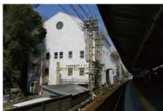
昭和4年建造の瀬戸変電所
