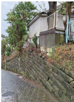
聖坂方面へ下る坂道沿いの「ブラフ積み」擁壁。車庫の一部が右側に見える
