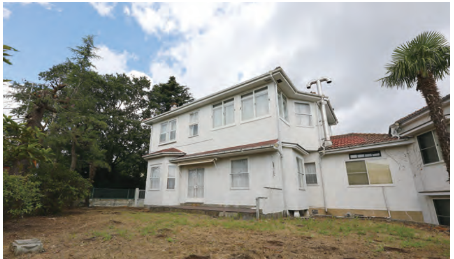
南(庭園)側の外観。大きな開口部(窓、扉)が特徴
