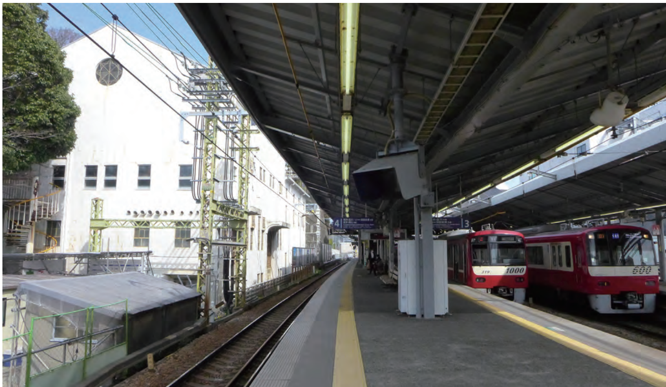
京急金沢八景駅上りホーム脇に佇む存在感ある瀬戸変電所(撮影・米山淳一)
