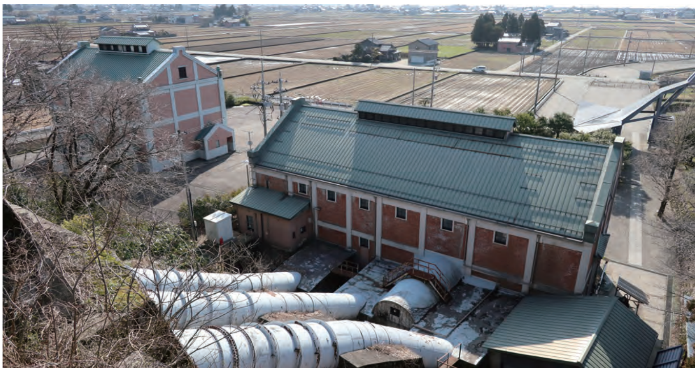
河岸段丘の上から見た発電所美術館(旧黒部川第二発電所)。水路式発電所の仕組みを今も確認できる。左手は、1992年(平成4)に新築された新黒部川第三発電所。周辺には散居村が広がっている
