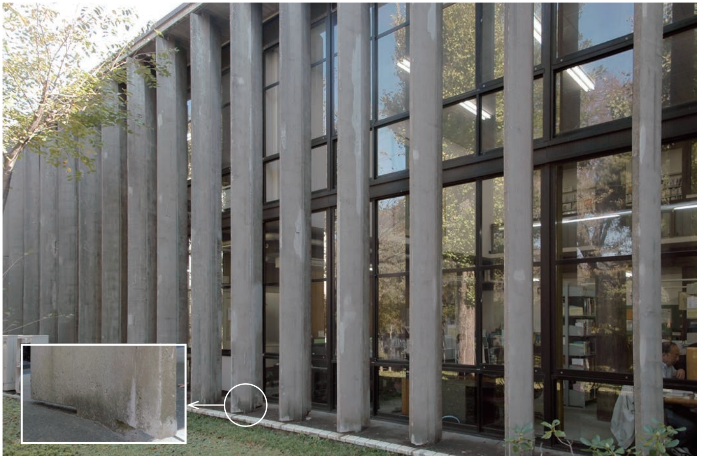
神奈川県立図書館北側ファサード。ブリーズ・ソレイユの下部細部。柱が浮いているように見える(写真/吉田銅市)
