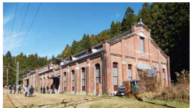
⑤丸山変電所(国の重要文化財で、碓氷峠鉄道文化むらと碓氷第3橋梁中間に残る2棟の煉瓦構造物)
