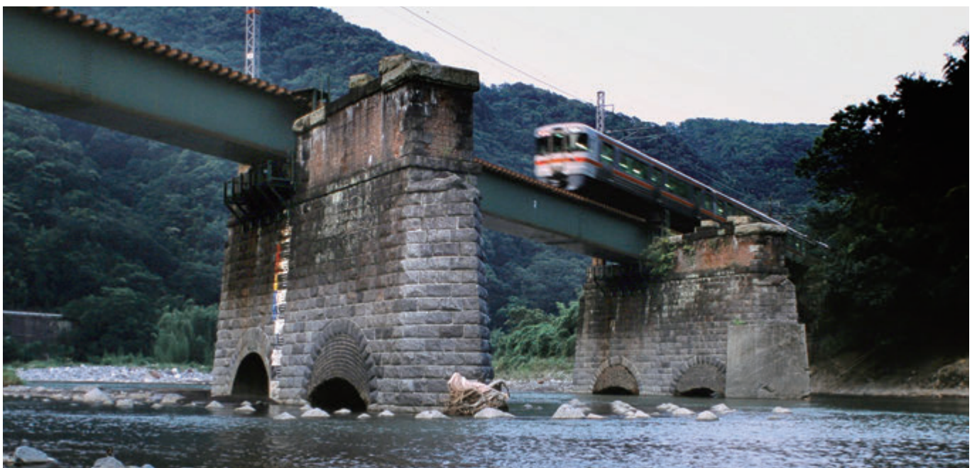
御殿場線の単線化された橋梁
