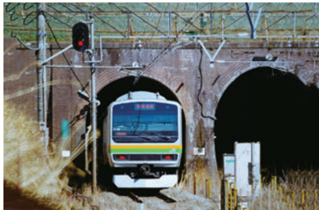
清水谷戸トンネル
