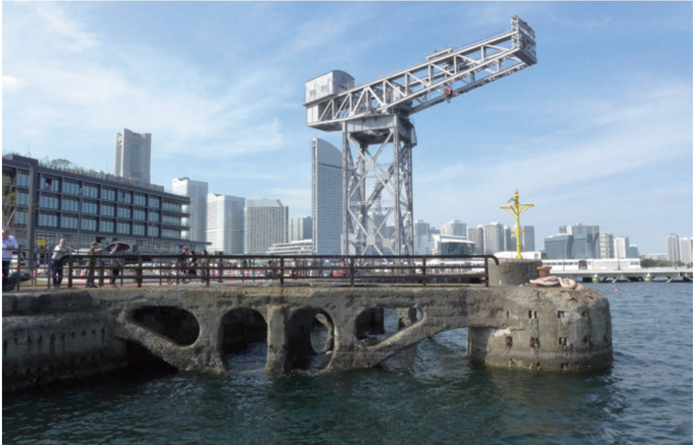
船と鉄道との間の荷役を担ったハンマーヘッドクレーン。港のシンボルは、鉄道遺産でもある (写真/米山淳一)
