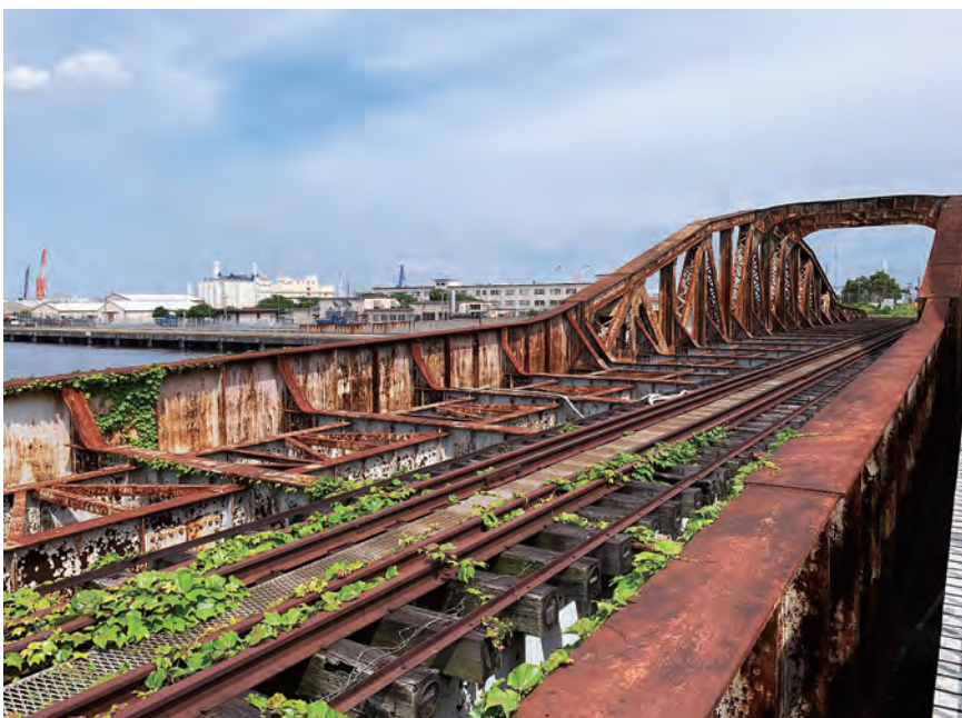
横浜臨港線の瑞穂橋梁はそれまでのリベット構造と日本初の溶接工法の両方の技術で造られた貴重な鉄道橋
