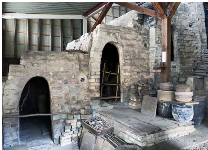
井上良斎窯場には煉瓦造りの希少な登り窯が保存されている
